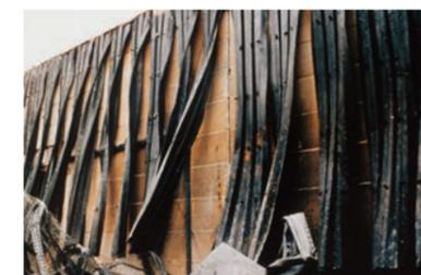
Un feu créé par une source extérieure (incendie, explosion) peut mener à la destruction du bâtiment si la toiture n'est pas résistante au feu.
