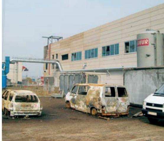
L'explosion d'un gazoduc a provoqué l'embrasement de véhicules situés à plusieurs centaines de mètres. Pourtant, l'incendie ne s'est pas propagé aux bâtiments adjacents. Un mur extérieur en béton cellulaire a offert une protection sûre contre la pénétration des flammes et de la chaleur.
